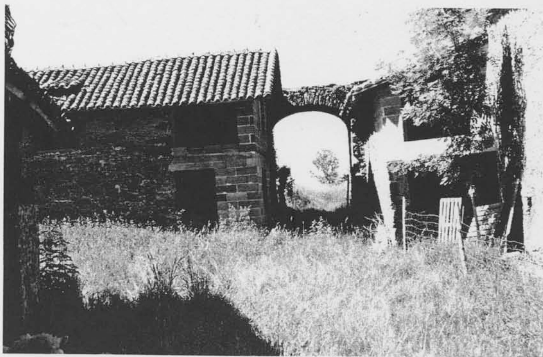
Le porche vue intérieure
