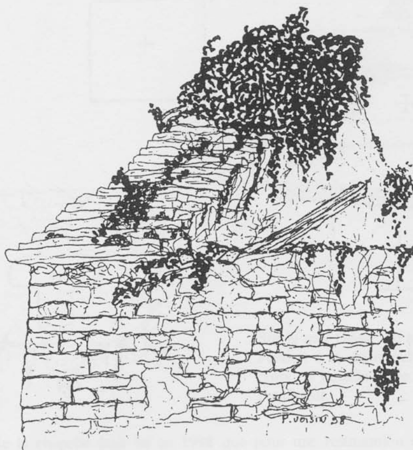
Redents en lauzes de schistes posées en recouvrement sur les rampants du pignon Sud-Est.
